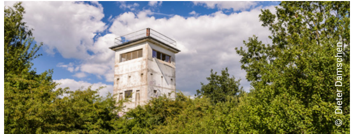
In Hoyersburg ist noch ein ehemaliger Grenzturm erhalten und im Besitz des BUND.
